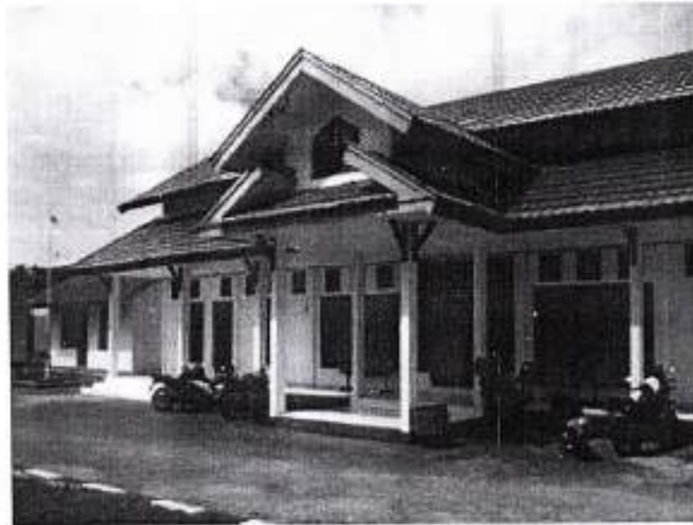
Gambar 2.1. Bangunan Kantor Administrasi Bandara
